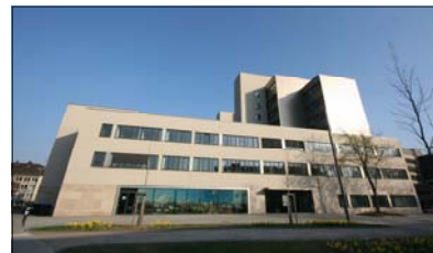
Sparkasse Duisburg belegt Restflächen über rd. 1.200 m 2 im Kuhlenwall-Karree selbst
