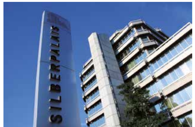
Am Silberpalais 1-3, CUBION vermietet 6.550 m 2
